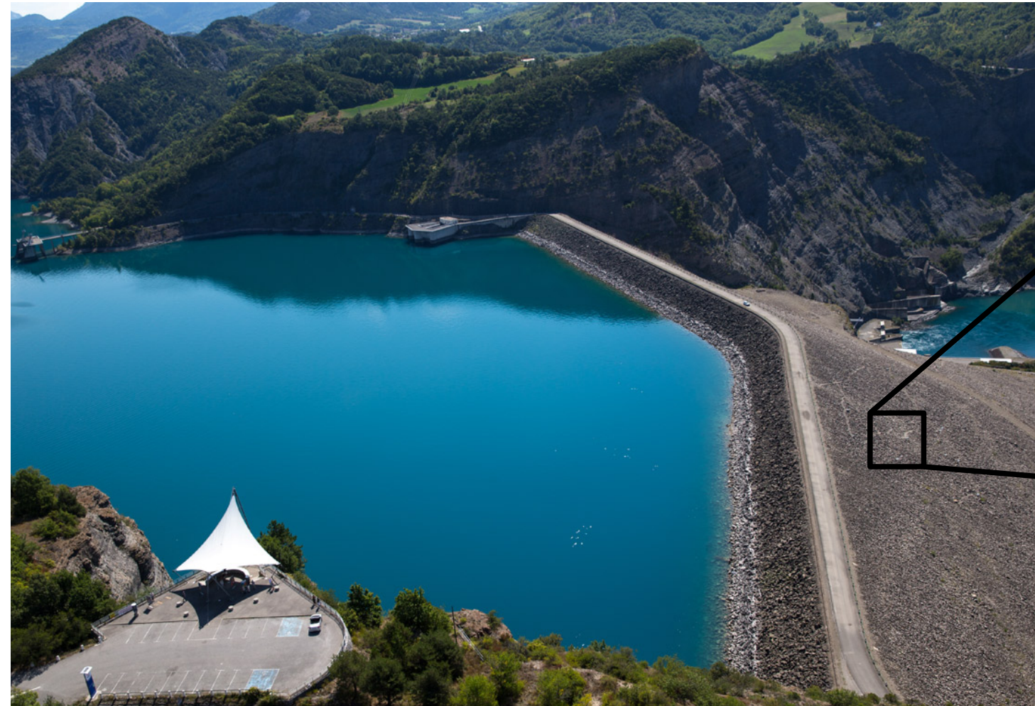
Serre-Ponçon rockfill dam, 123 m
