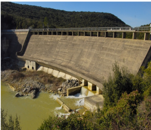
Barrage de la Rouvière – Retenue vide
